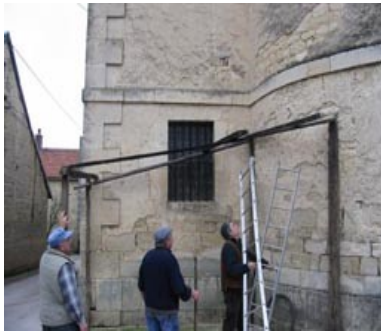
Construction de l'abri le long de l'église
